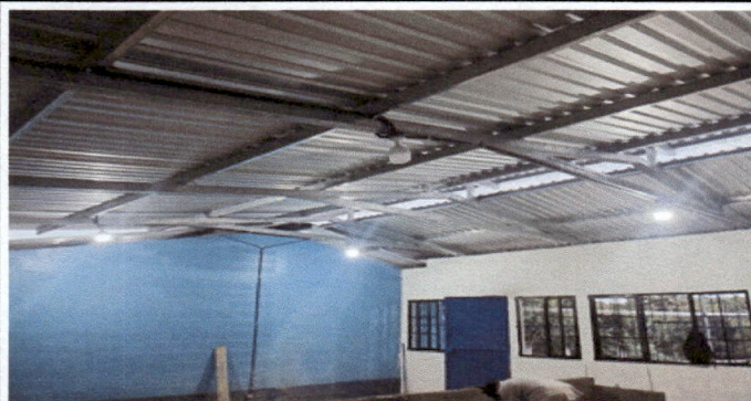
Foto1: Cubierta de laminas ,estructura de techo y Energia Electrica; Cada uno de los trabajos detallados con anterioridad se ejecutaron al 100%
