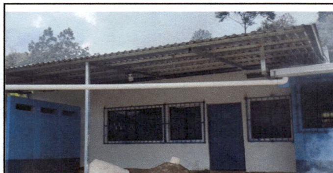
Foto 6:Techo Corredor; Se le agrego lamina y estructura metalica al corredor de la cocina y se termino al 100%
