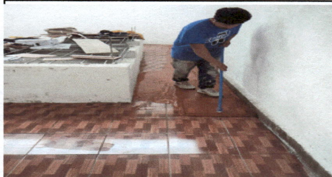
Foto 2: Torta y Piso Ceramico; Los trabajos descritos anteriormente se ejecutaron al 100%
