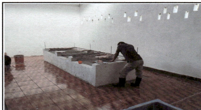
Foto 4: Poyeton; Se realizo un nuevo poyeton y se finalizo al 100%
