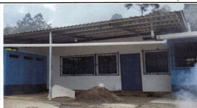
Foto 3:Ventanas y Puerta; se Trabajaron al 100%
