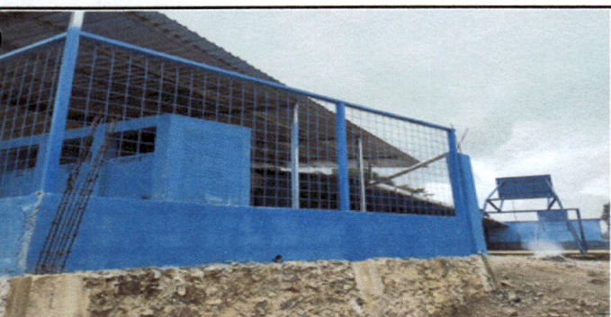
Foto 5: Muro Perimetral; Se realizo el muro perimetral, se le coloco electromalla y se finalizo al 100%
